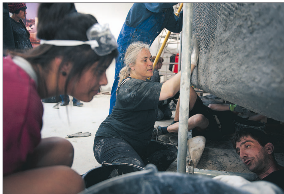
Marit Benthe Norheim (i midten) og de mange frivillige kom på en hård opgave. Al beton skal lægges på og glattes ud med håndkraft.
