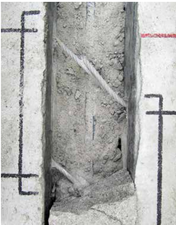
Elementerne samles med indstøbte wiresløjfer omkring en armeringsstang, hvorefter samlingen udstøbes med fugebeton.
