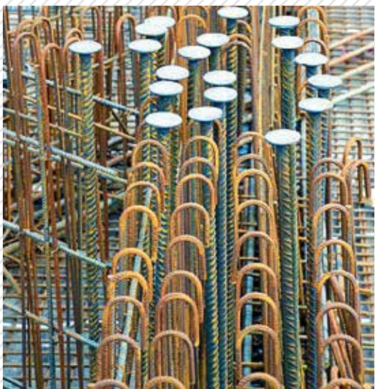
Gennemlokningsarmering som anvendt i Aarhus. Foto: Peikko.
