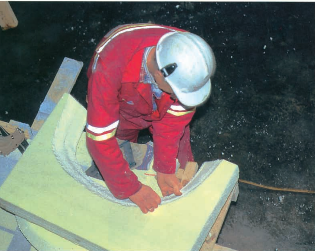
Rompeballene skjæres til i isopor før de festes med jernstenger og plank til støpen.
