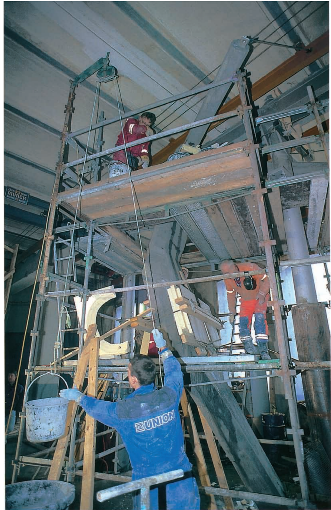
Ketil har blandet mørtelen, som heises opp til en utålmodig Palmer på stillaset.
