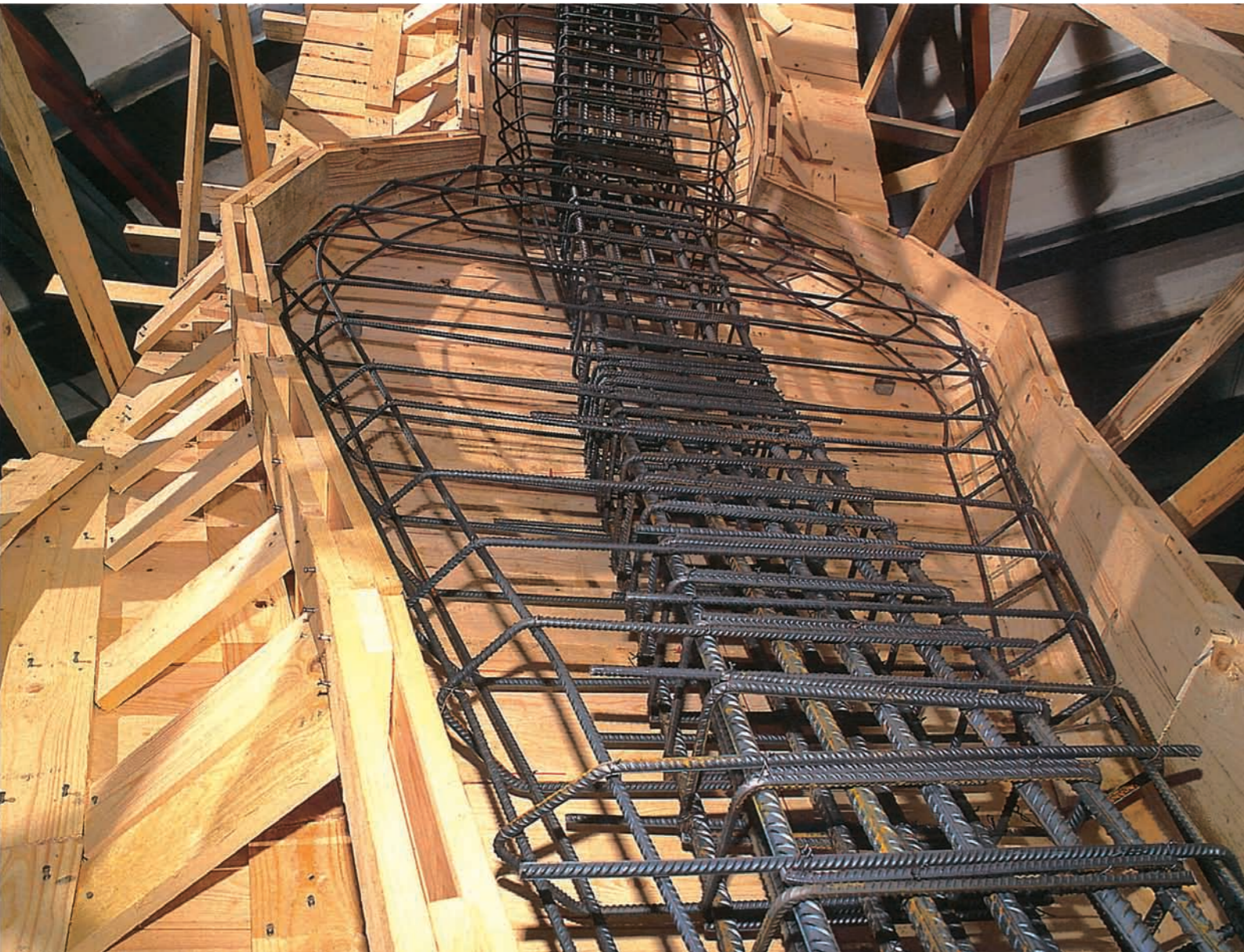
Når søylen er klar, bindes et slags strutteskjørt rundt hofter og overkropp. Jernbindingen er utrolig flott. En grov og elegant skulptur.
