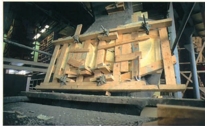
Rompeballene skjæres til i isopor før de festes med jernstenger og plank til støpen.
